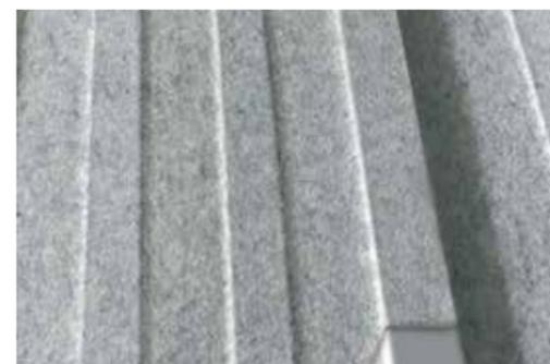
Detalj protukondenznog filca na trapeznom limu TR 40
