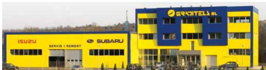
Prodajno - servisni centar "Graditelj BL" Kladuša - izrada fasade od panela i pokrivanje krova trapeznom limom
