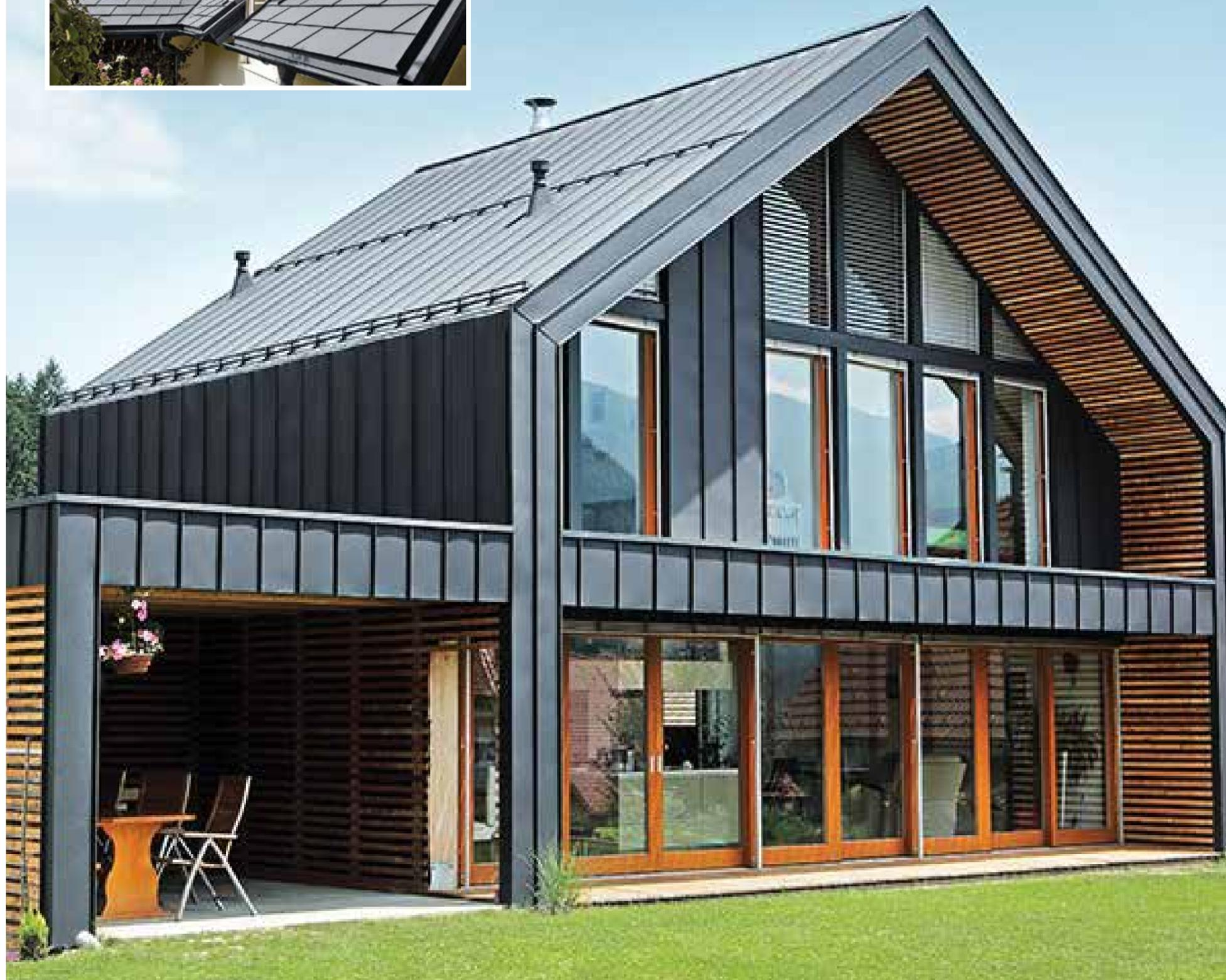
Osnovni materijal za PREFA pokrove je aluminijski lim proizveden prema leguri EN 1396.
